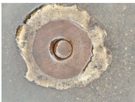
ภาพที่ 3.2.4-2 รังวัดค่าพิกัดหมุดควบคุมโครงการด้วยเครื่องรับดาวเทียม GNSS
